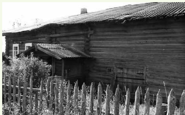
Рис. 5. Двускатно-симметричный навес крыльца в одном из домов д. Чукаиб Сысольского района Республики Коми. Фото автора. 2014 г.
