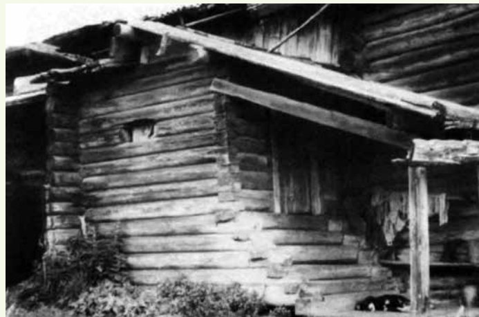
Рис. 1. Глухое бревенчатое крыльцо в одном из домов в д. Гёрд Кър Прилузского района Республики Коми (Шургин И. Н. От лесной избушки до церкви дивной: Деревянная архитектура коми. М., 2009. С. 223)
