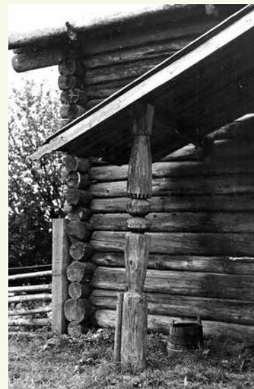
Рис. 7. Поддерживающий кровлю крыльца столб в одном из домов д. Шорйив Сысольского района Республики Коми. Фото И. Н. Шургина. 1973 г.
