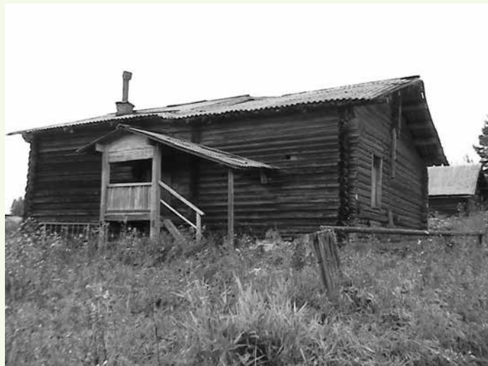
Рис. 6. Двускатно-асимметричный навес крыльца в одном из домов с. Межадор Сысольского района Республики Коми. Фото автора. 2013 г.
