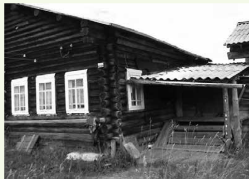
Рис. 4. Односкатный козырек крыльца дома Л. Ф. Юговой в д. Бубдор Сысольского района Республики Коми. Фото автора. 2012 г.
